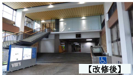
写真一 正面玄関の特定天井の改修
