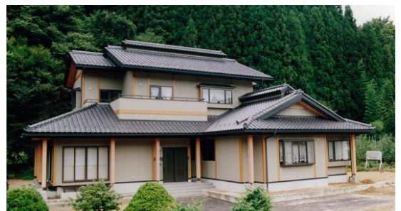
和風の2世帯住宅
