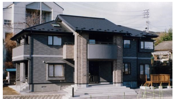
和洋の2世帯住宅
