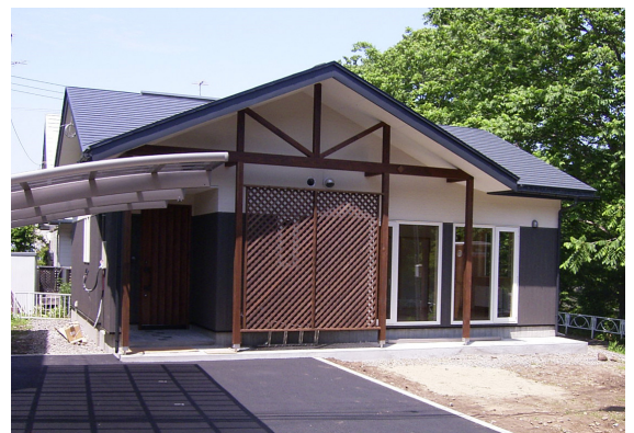
コンパクトハウス外観
