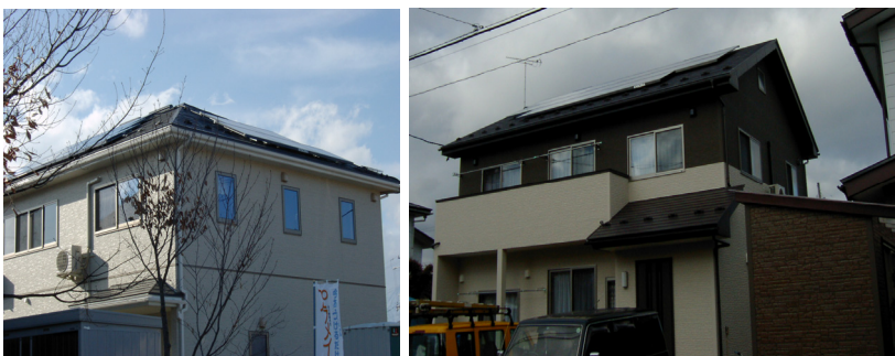
太陽光発電付きオール電化住宅（太陽光発電パネル取付は自社施工）
