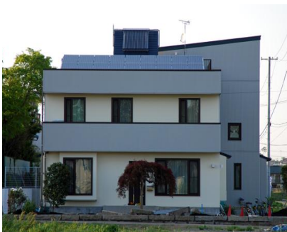
環境エネルギー利用住宅 写真1
