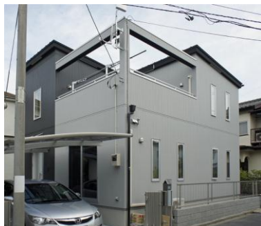
環境エネルギー利用住宅 写真2
