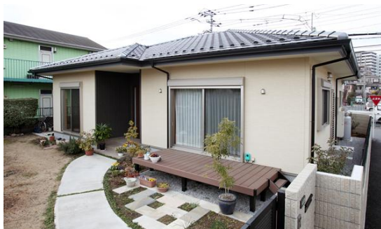
光熱費に負担を掛けない、高齢者に優しい平屋による住まい造り 写真4
