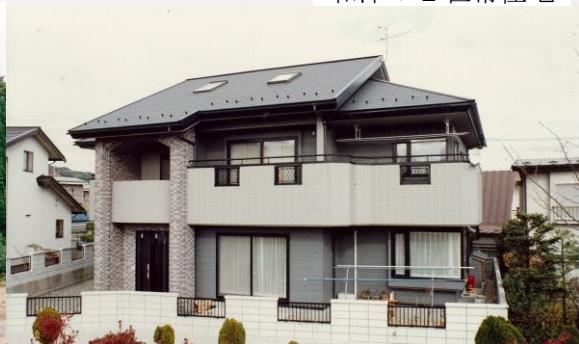
和洋の 2 世帯住宅
