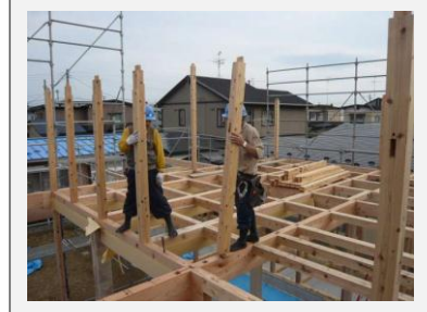
現場での組立作業のようす
