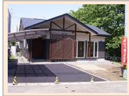
コンパクトハウス外観
