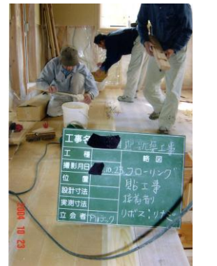
フローリングを貼っているところ
