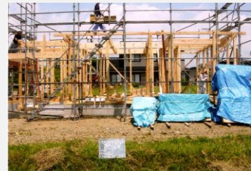
県産材の建て方
