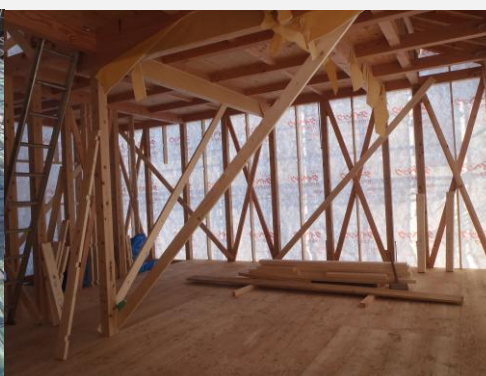
在来軸組工法に基づく住宅躯体
